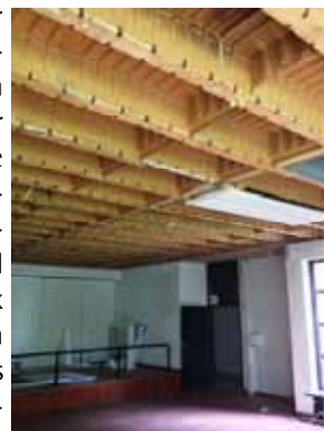
In diesem Bereich steht dann die neue Orgel. Wie wohl die neue Decke aussehen wird?
