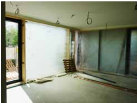
Hier entsteht die „Turnhalle“
